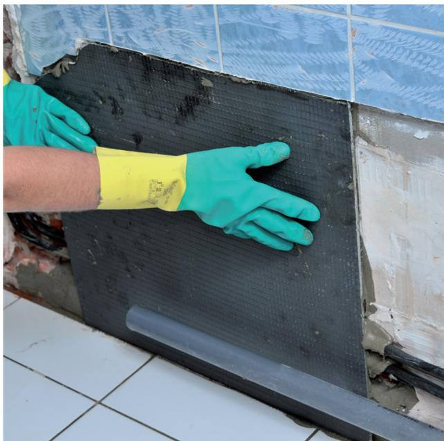
Positionieren Sie die Platte auf die vorgesehene Fläche. Drücken Sie die Platte auf den Untergrund, um eine optimale Kleber-Übertragung zu gewährleisten.
