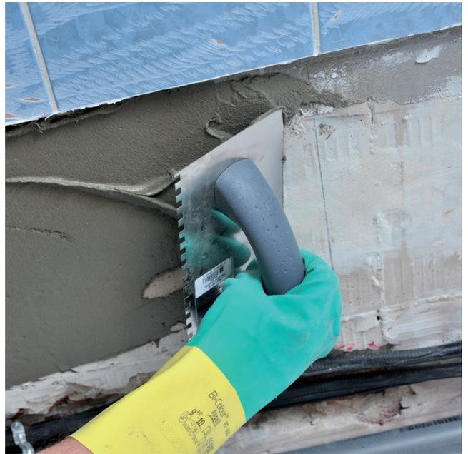
Den Klebemörtel mit einer U6-Zahnkelle auf den entsprechenden Untergrund auftragen.
