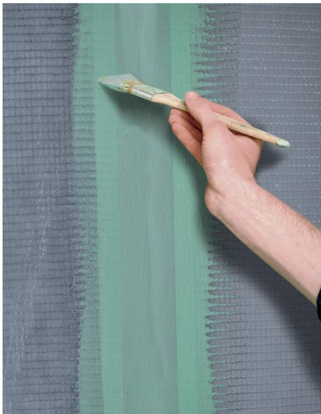
Jeder Eck- oder Plattenanschluss muss mit einem Dichtband abgedeckt werden. Das Dichtband mit frischem Mörtel mithilfe eines Pinsels auf die Platten verkleben so es sich nicht um einen Nassraum handelt. Ansonsten ist das Dichtband mit einem Abdichtungsprodukt wie CERMICRYL auf die Bauplatten zu verkleben.
