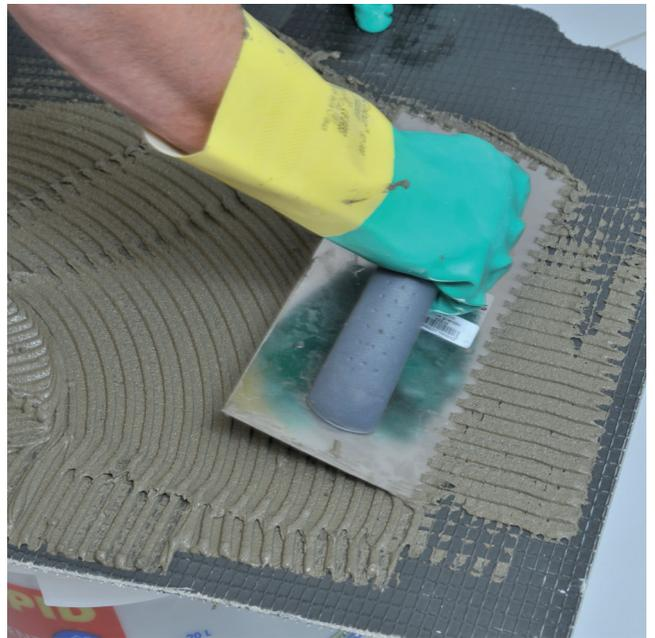
In gleicher Weise den Klebemörtel mit der Zahnkelle auf die Rückseite der zu verklebenden Fliese auftragen.
