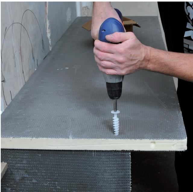
Nach dem Verkleben, die Bauplatte alle 20 cm mittels Polyamid Dübeln auf die Stützelemente befestigen.
