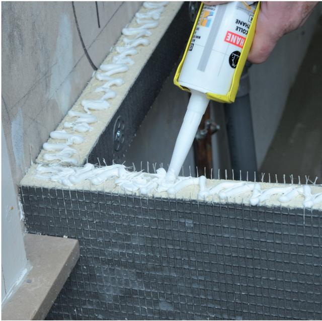
Die verschiedenen Bauplattenelemente mit CERMITHANE (in einer Kartuschenpresse) verbinden und abdichten.
