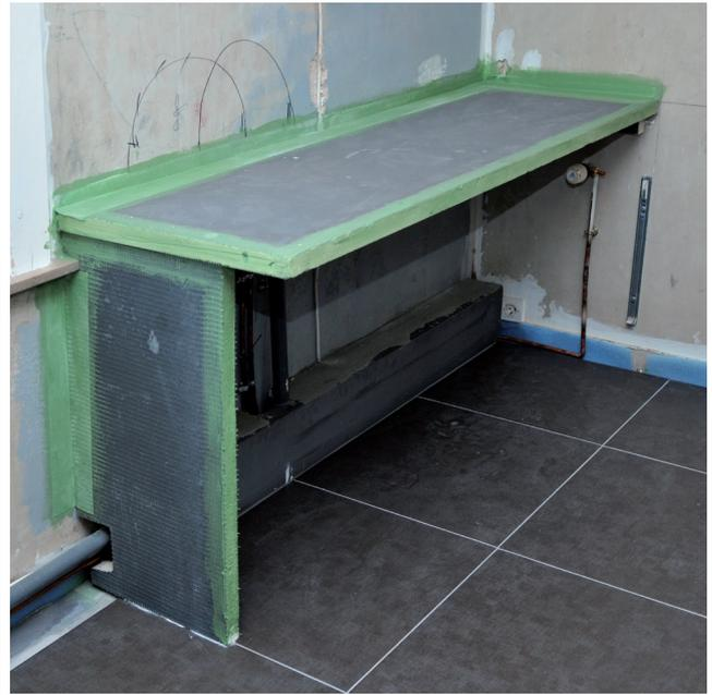
Plattenverbindungen und Wandanschlüsse mit dem Dichtband AR12C und CERMICRYL abdichten.
