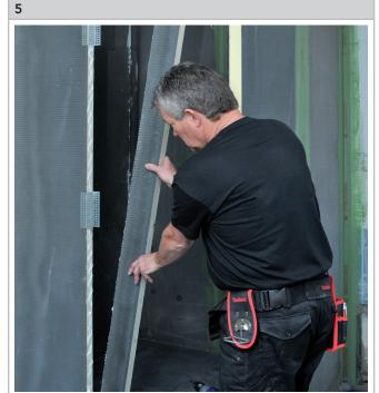
Die Bauplatten in die Verankerung einführen.
