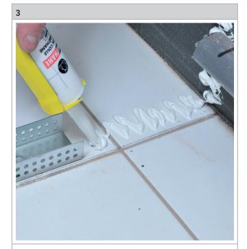
Tragen Sie mit einer mechanischen Pistole eine Schicht CERMITHANE über die gesamte Länge auf.
