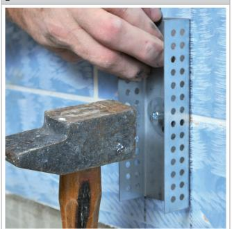
Befestigen Sie den U-förmigen Anker mit Einschlagstiften und Metallrondellen an Wand und Boden.
