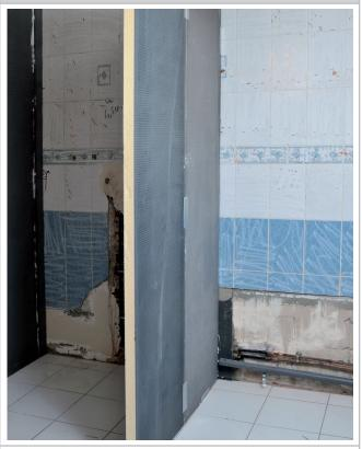
Die Seiten der Bauplatten, bei denen das Polystyrol sichtbar ist, sind mit CERMICRYL abzudichten. Anschliessend kann die Zwischenwand mit Fliesen verlegt werden.
