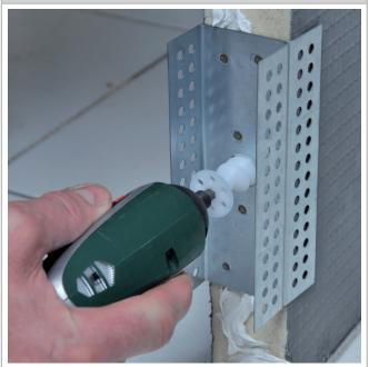
Vor der Befestigung der nächsten Bauplatten eine Schicht CERMITHANE über die Gesamtlänge der Schmalseite der Bauplatte auftragen. Anschliessend alle 1 Meter eine "H"-Wandverankerung mit einem Polyamid Dübel fixieren.
