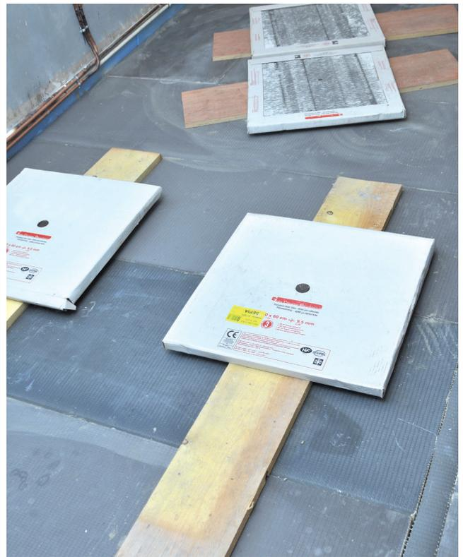
Um sicherzustellen, dass die Bauplatten vollständig und eben verklebt sind, empfehlen wir diese bis zu 24 Std zu belasten (z.B. mit Hilfe langer Bretter und Gewichten).
