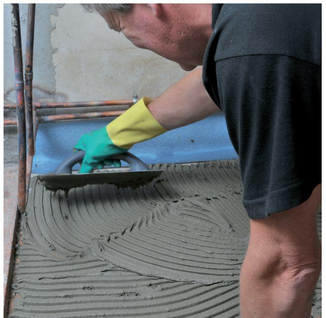
Tragen Sie einen C2- oder C2S1 / S2-CERMIX-Klebmörtel mit einer U9-Zahnkelle auf.
