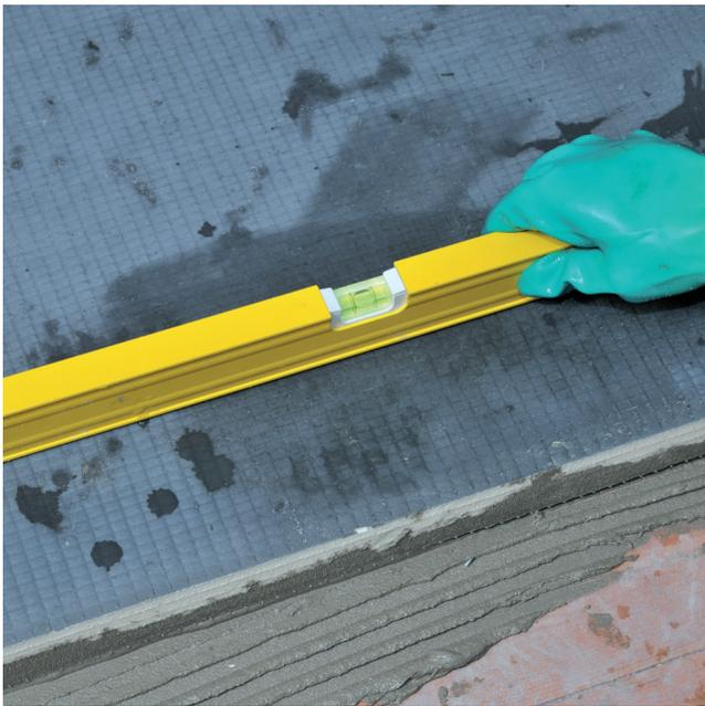
Die Bauplatte korrekt positionieren und in den Klebemörtel eindrücken. Ebenheit immer überprüfen.
