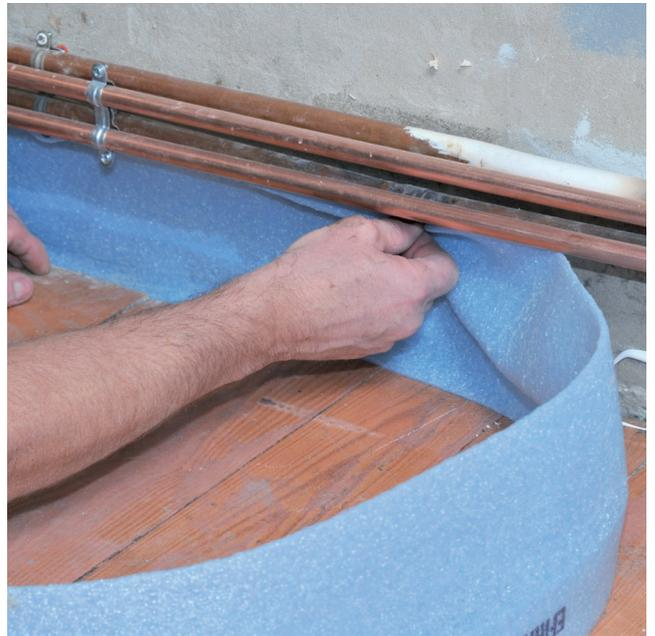
Nach dem Abtrocknen der aufgetragenen CERMIPRIM RAPID Grundierung (bei Holzböden) einen Randdämmstreifen rund um den Raum.
