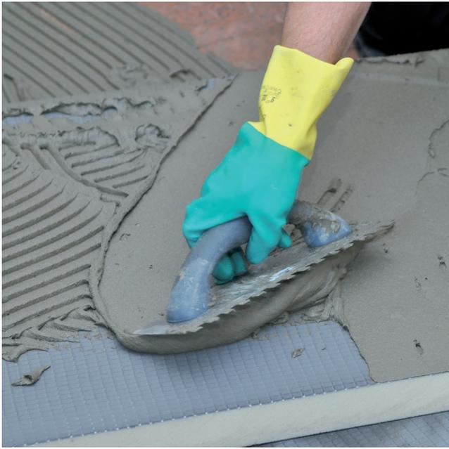
Die Bauplatten sind doppelseitig zu Verkleben (Klebemörtel auf den Boden und die Rückseite der Bauplatte).
