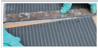
Bei dünnen Platten (≤ 20 mm) reicht ein einziger Arbeitsgang mit dem Cutter aus, um die Platte zu schneiden. Bei dickeren Platten zwei Arbeitsgänge ausführen (der erste wird nur zum Schneiden der Beschichtung und der Faser verwendet).
