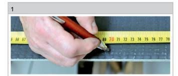
Messen Sie die Länge der zuzuschneidenden Platte mit einem Meterstab oder Messband.
