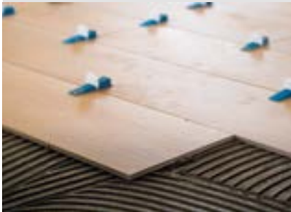
POSE DE CARRELAGE FLIESENVERLEGUNG
