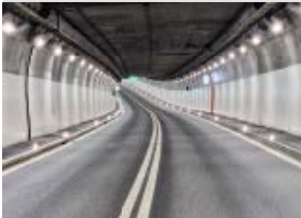
TRAVAUX DE GÉNIE CIVIL TIEFBAU
