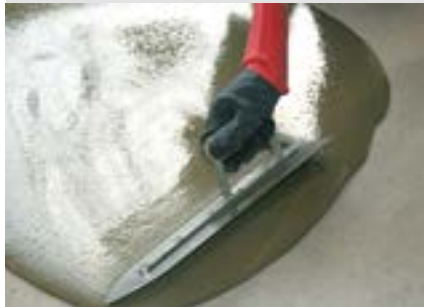
PRÉPARATION DE SOL VORBEREITUNG DES UNTERGRUNDS
