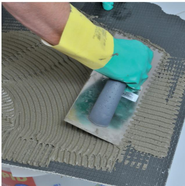
De la même manière, appliquer le mortier colle à l'aide d'une spatule crantée sur le panneau à coller.
