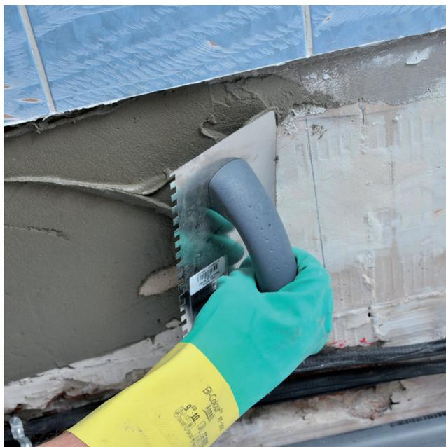
Appliquer le mortier colle à l'aide d'une spatule crantée U6 sur le support prévu pour accueillir le panneau.
