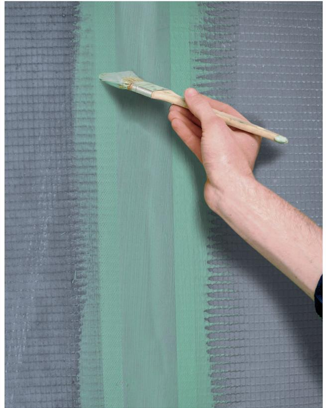
Chaque raccord d'angle ou de panneau doit être recouvert d'une bande d'étanchéité.
