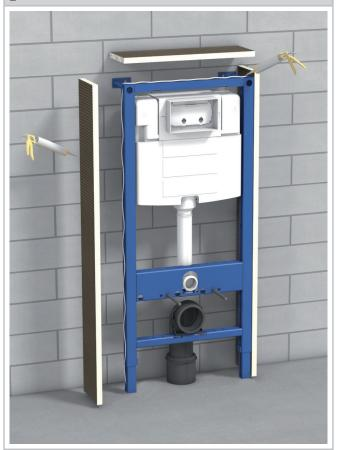
Coller les panneaux au Cermithane directement sur l'armature métallique du toilette suspendu.
