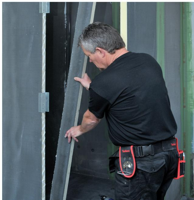
Positionner les panneaux dans les ancrages mis en place.
