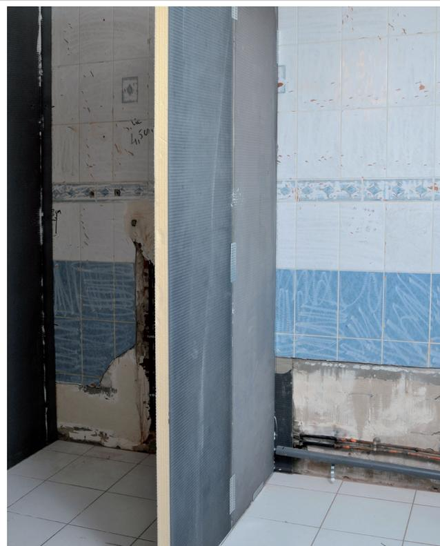
Étancher les faces des panneaux dont le polystyrène est apparent à l'aide de CERMICRYL. Votre cloison est prête pour être utilisée comme un support prêt à carrelar.
