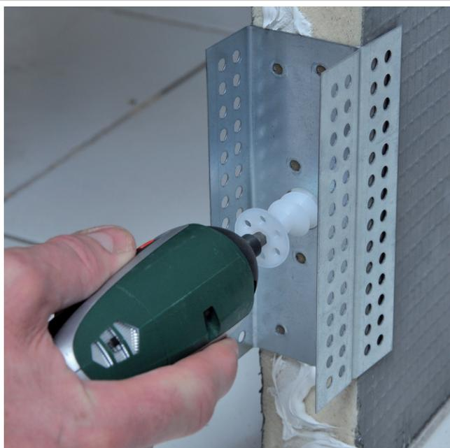
Avant de placer les panneaux suivants, appliquer un cordon de CERMITHANE sur l'épaisseur de chaque plaque. Placer ensuite un ancrage en «H» à l'aide d'une cheville polyamide tous les 1 m environ.
