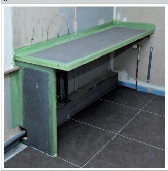
Armer toutes les jointures et chants des panneaux avec la bande d'armature AR12C et le CERMICRYL.
