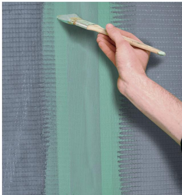
Chaque raccord d'angle ou de panneau doit être recouvert d'une bande d'étanchéité. Poser la bande et la maroufler dans un mortier fraîchement appliqué au pinceau lorsque vous n'êtes pas en milieu humide. Préférer un produit d'étanchéité liquide (type Cermicryl) pour une utilisation en milieu humide.
