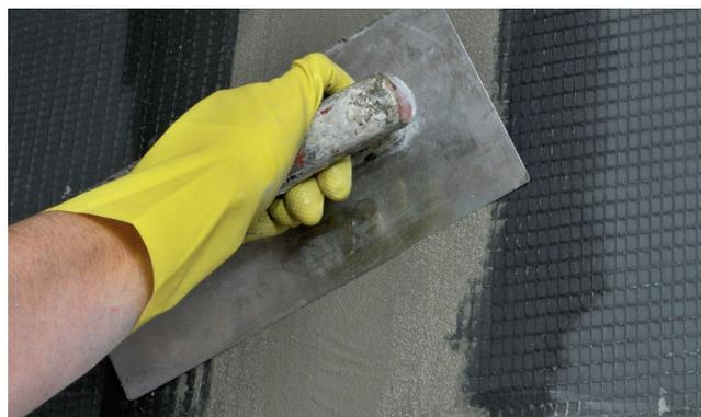
Après avoir lissé le mortier colle à l'aide d'une taloche, le support est prêt à être carrelé.
