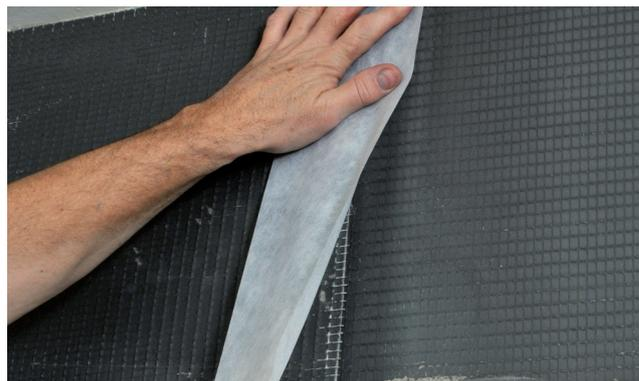
Découper la bande à la longueur souhaitée à l'aide d'un cutter ou d'une paire de ciseaux.
