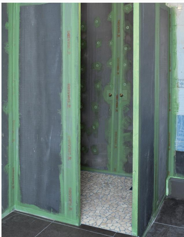
L'étanchéité des parois et vos jointures faites, votre support peut être carrelé.
