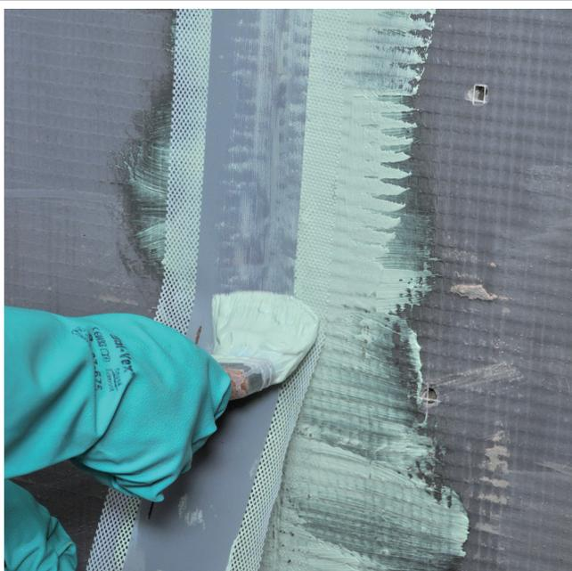
Disposer la bande d'armature sur le CERMICRYL encore frais.
