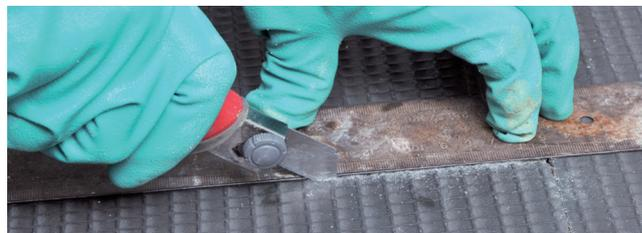
Découper le panneau au cutter en suivant la ligne préalablement tracée.
