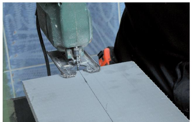
Bien découper en suivant la ligne de découpe (des lames spécifiques sont recommandées pour de tels travaux).
