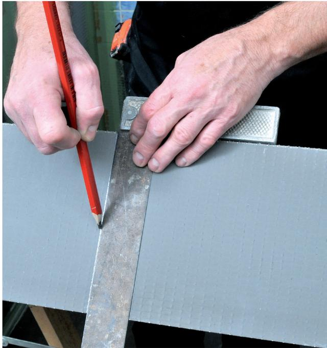
Tracer à l'aide d'un crayon ou d'un feutre une ligne de coupe pour l'incision.
