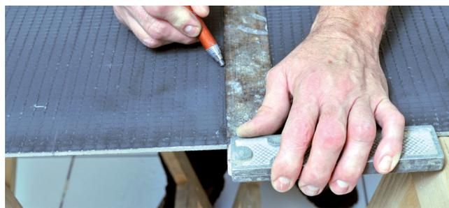
Tracer à l'aide d'un crayon ou d'un feutre une ligne de découpe avec une règle.
