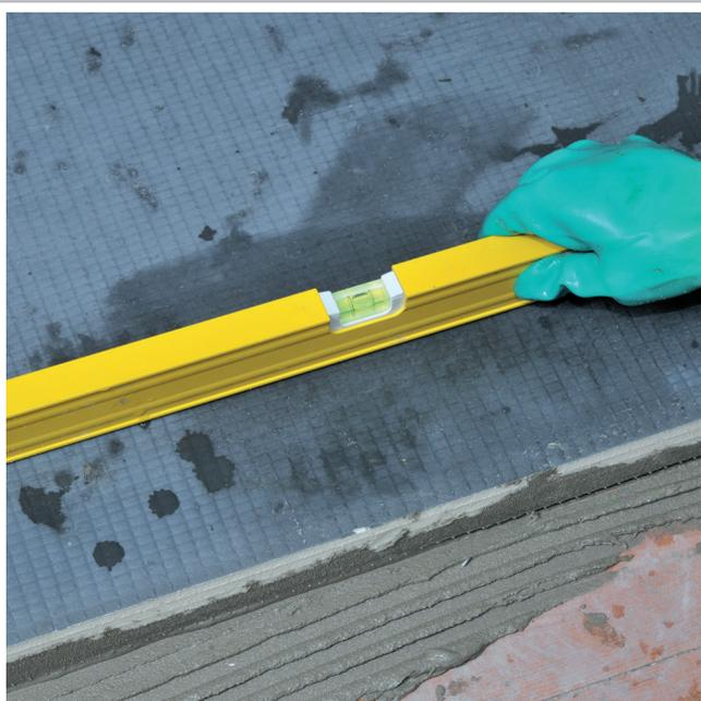
Positionner et appliquer le panneau au sol. Vérifier le niveau.
