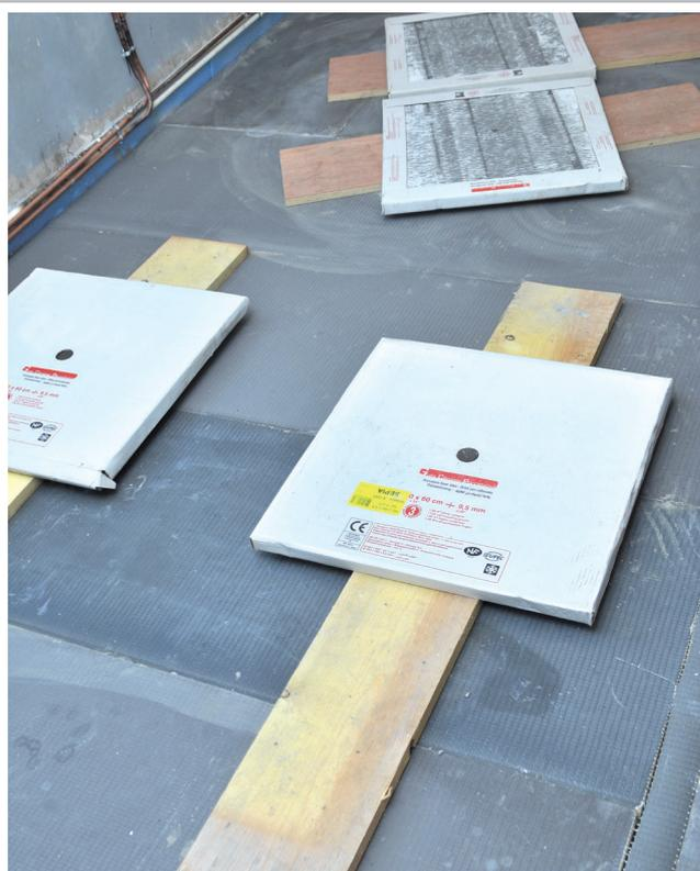
Pour s'assurer que les panneaux adhèrent pleinement au support d'une façon plane, n'hésiter pas à poser du poids dessus (par exemple avec l'aide de longues planches) pendant près de 24 heures.
