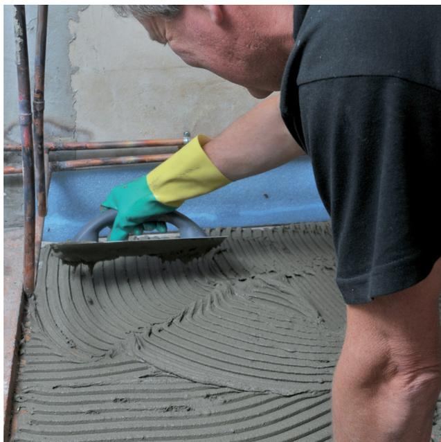
Appliquer un mortier colle CERMIX classé C2 ou C2S1/S2 à l'aide d'une spatule crantée de 9 mm.
