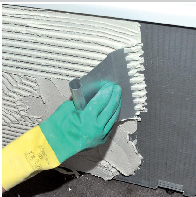
Utiliser une spatule crantée pour bien étaler le mortier colle sur le support et pour qu'il y ait un bon transfert de colle avec le carreau.
