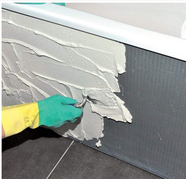
Le tablier de baignoire est prêt à être carrelé. Utiliser une spatule (ou une truelle) pour appliquer le mortier colle.
