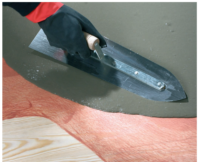
Verlegen auf Holz: In Verbindung mit de Faserarmierten Ausgleichmassen RAGRENOV S30 oder RAGREFOR
