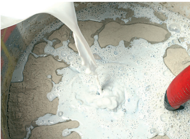
Bei Zugabe von Anmachwasser
