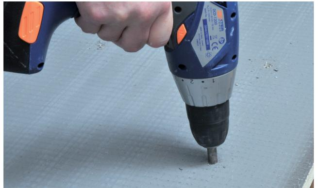
Legen Sie die Platte flach auf den Bohnen und bohren Sie die Positionen der Dübel ca. alle 30 cm (vorgebohrt).
