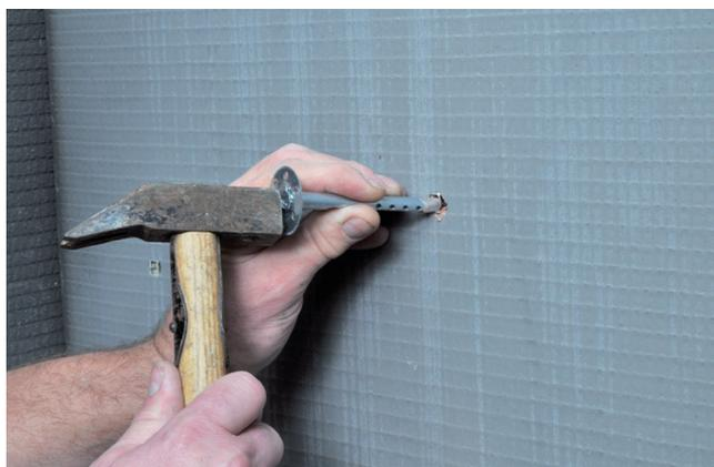
Schieben Sie die Metalldübeln in jede Vorbohrung.
