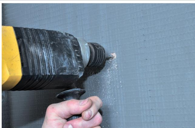
Bohren Sie nach dem Trocknen des Klebemörtels in jedes Vorloch.
