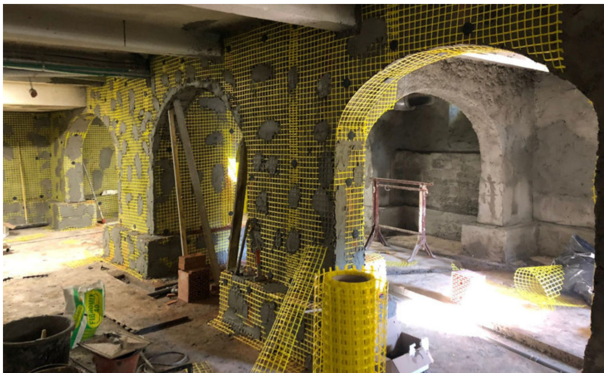
Illustration d'application du treillis SEALBAND en combinaison avec l'enduit d'imperméabilisation CERMIPROOF SEAL G
