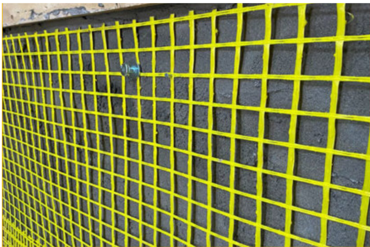
Fixation du treillis SEALBAND sur les fixations adaptées (pointes, clous ou agrafes traitées contre la corrosion)
